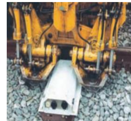
Компактный стальной брус с переводными устройствами заменяет собой шпалу и позволяет машинную подбивку балласта
