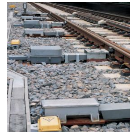
устройство контроля прижатия остряка
